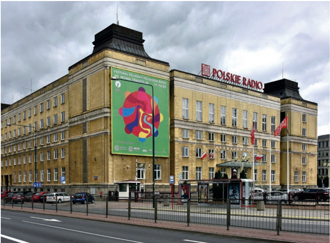
Budynek Polskiego Radia przy al. Niepodległości 77/85 w Warszawie, 2017, fot. Adrian Gryczuk, fot. Wikimedia Commons, licencja CC
